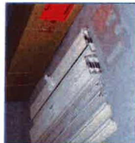
4/ Positionner la vis **b**, et visser le rail à la rive à l'aide d'un tournevis ou d'une visseuse.
