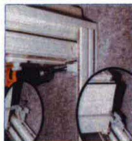
9/ Procéder à un test de fermeture de la persienne. Attention à bien positionner la lame finale du paquet droit sur le pion présent dans le rail. Verrouiller alors la poignée grenouillère.
