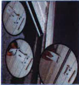
3/ Positionner l'escargot **a**, en bout de rive et venir le plier au contact du paquet de lames. REPLIER CENTRÉ DÉFORMATION 4 SOUS, POUR FAIRE UN ESCARGOT À CHAQUE EXTRÉMITÉ DE RIVE.
