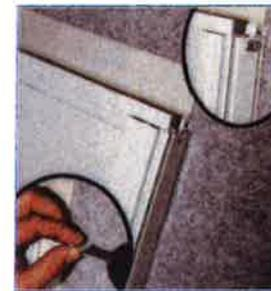
11/ Incliner la butée d'arrêt de vent **d** et la clipser dans le rail bas. Ouvrir le paquet et venir positionner l'arrêt au niveau de la languette basse. Visser.
