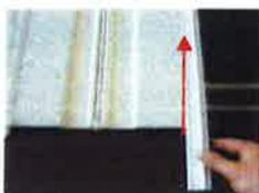
1 – Mettre en place les profils de rive C sur les paquets.
