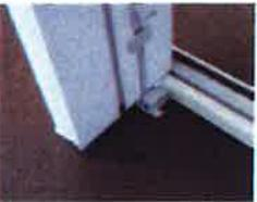
6 – Fixer en façade sur le rail bas les butées d'arrêt L.
